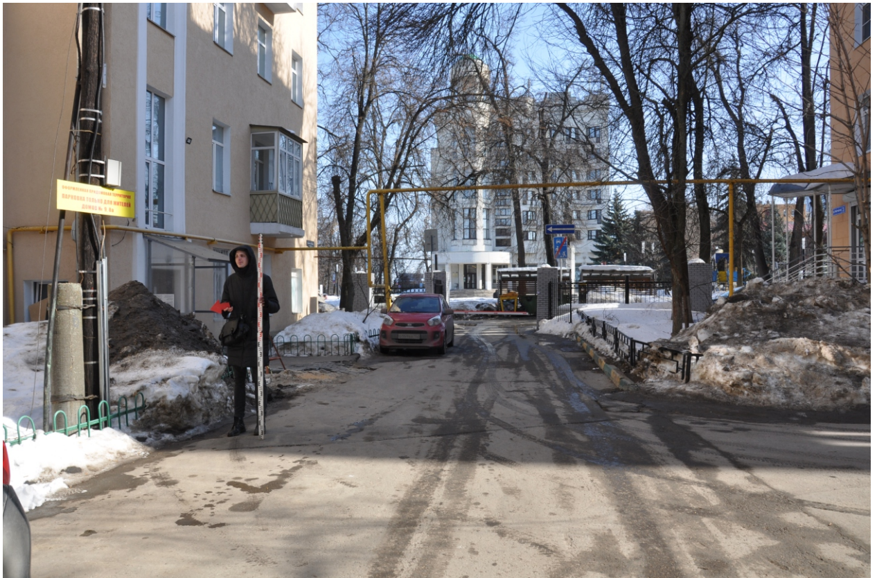
Рис. 12. Работы по объекту: «Строительство КЛ 0,4 кВ от опоры №6 ВЛ 0,4кВ ТП-215 Нагорного РЭС» по адресу: г. Н.Новгород, ул. Нестерова, д.3 2024 г. Точка фотофиксации 1. Вид с З.
