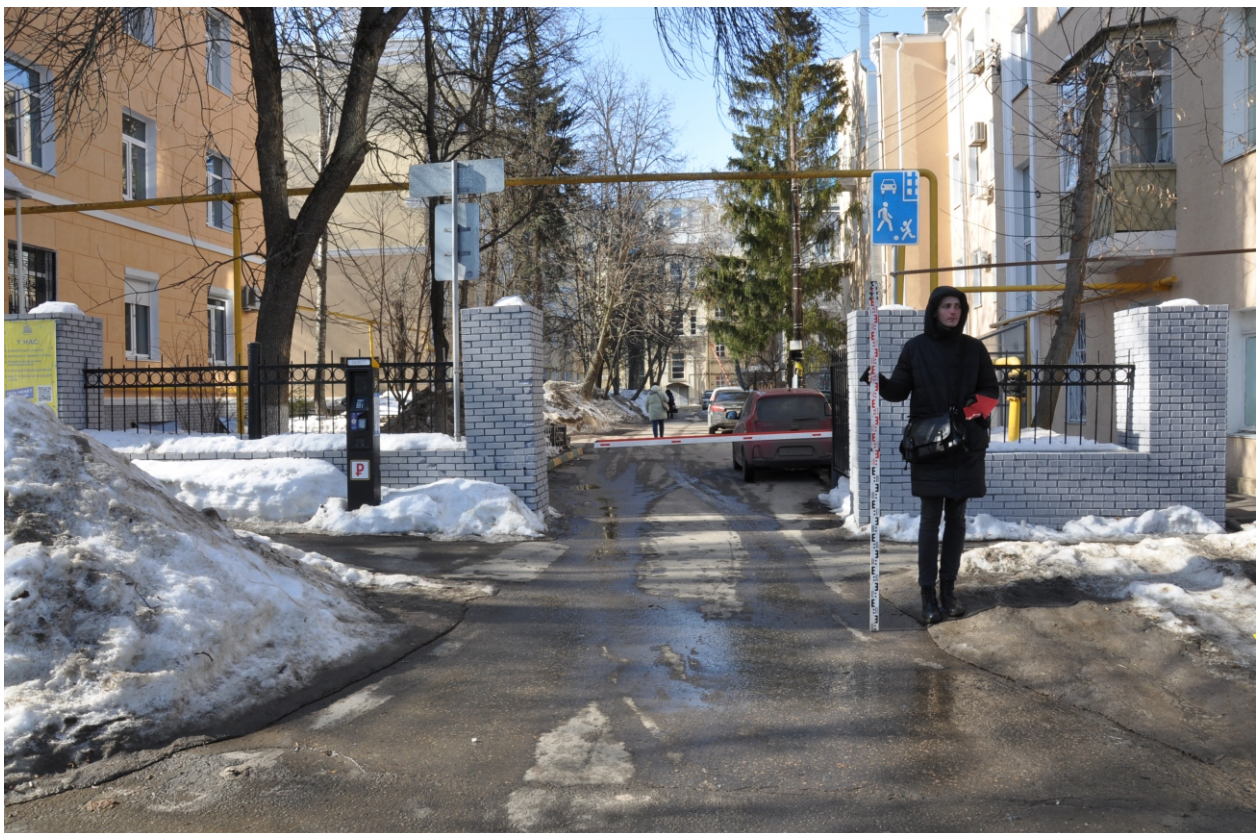
Рис. 11. Работы по объекту: «Строительство КЛ 0,4 кВ от опоры №6 ВЛ 0,4кВ ТП-215 Нагорного РЭС» по адресу: г. Н.Новгород, ул. Нестерова, д.3 2024 г. Точка фотофиксации 1. Вид с ЮВ.
