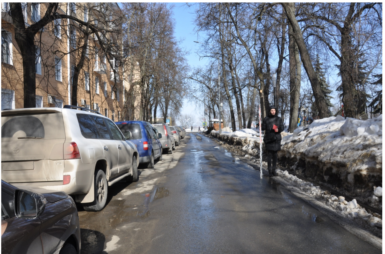
Рис. 13. Работы по объекту: «Строительство КЛ 0,4 кВ от опоры №6 ВЛ 0,4кВ ТП-215 Нагорного РЭС» по адресу: г. Н.Новгород, ул. Нестерова, д.3 2024 г. Точка фотофиксации 1. Вид с ЮЗ.
